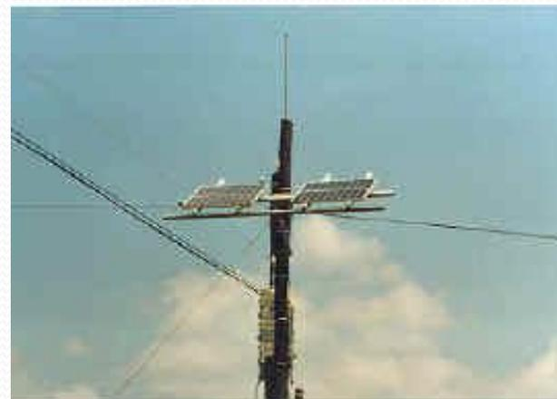
**STATION DE TELEMETRIE utilisant l'énergie solaire**
