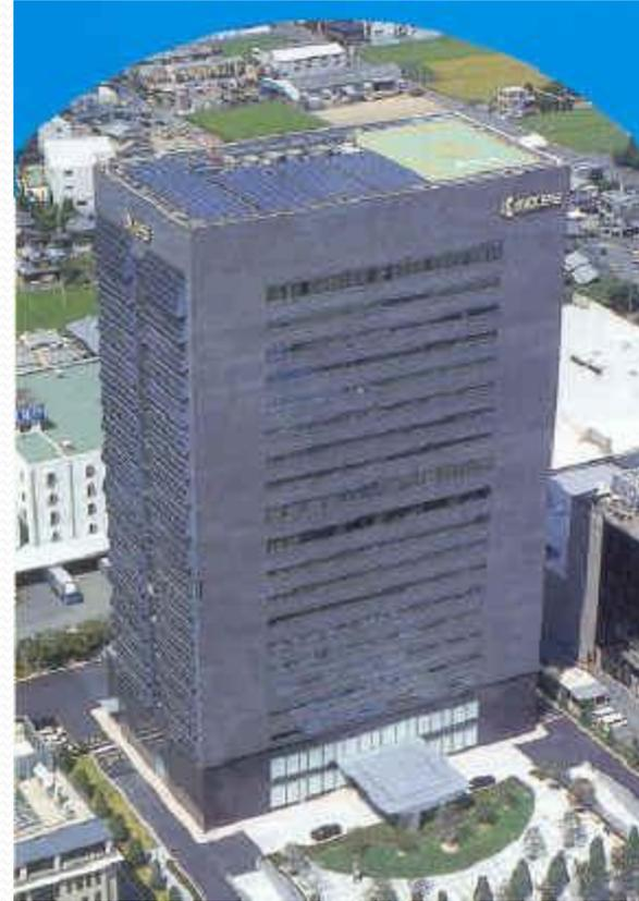
Des modules solaires totalisant 220KWp sur le toit et la façade sud du siège de Kyocera à Kyoto, le Japon prévoit des exigences de puissance électrique du bâtiment
