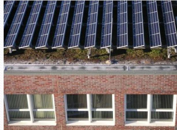
Exemple de l'optimisation des façades d'un immeuble par l'intégration de panneau solaire photovoltaïque à la verticale sur la partie haute du bâtiment et en inclinaison sur sa base.
